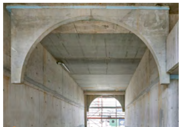
Im Pergolenviertel geht es im Großen wie in den Details der Haustechnik weiter.
