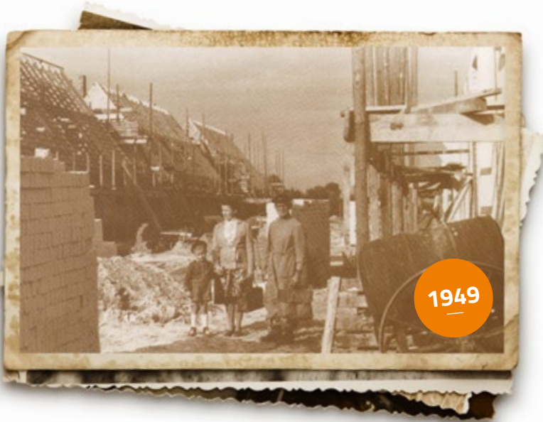
Das erste fluwog-Projekt: die Baustelle am Heerbuckhoop/Belemannweg im Stadtteil Langenhorn 1949
