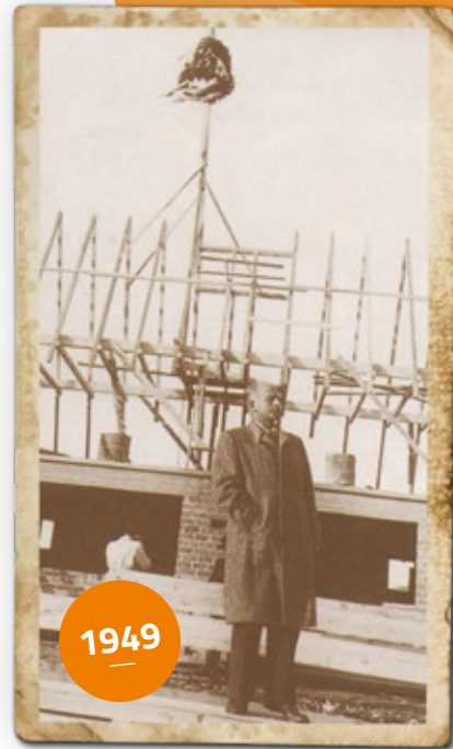
Bausenator Dr. Paul Nevermann am 06.07.1949 beim Richtfest auf der Baustelle in Langenhorn
